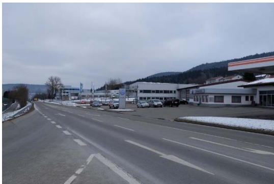
Foto 1: Projektstandort – Ansicht von der Wehinger Straße
